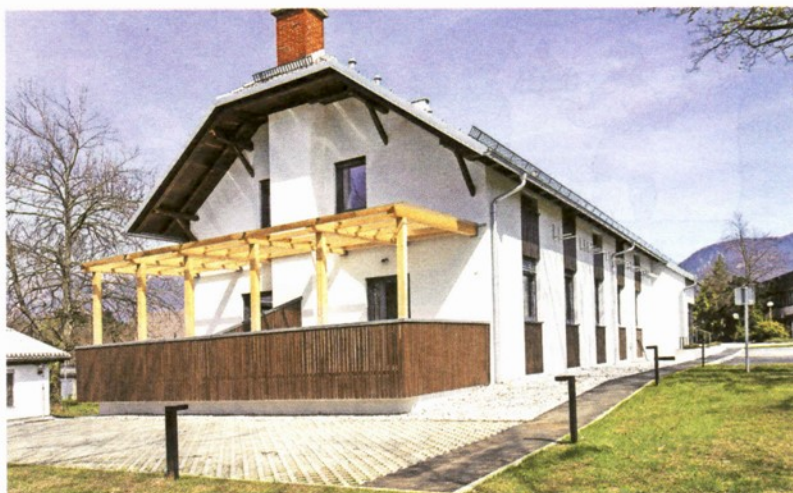
Stanovanja so uredili v stavbi nekdanje gostilne Kozolec, kjer je imelo pred prenovno prostore tudi društvo upokojencev. / FOTO: GORAZD KAVČIČ
