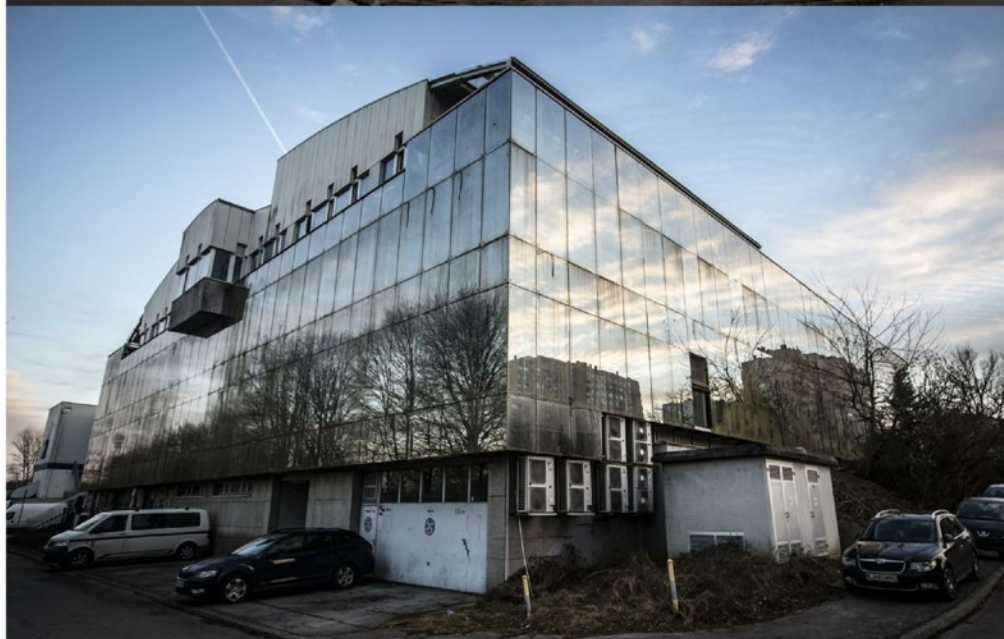
Stavbe na Litijski cesti trenutno ni mogoče uporabljati. Foto: Bojan Puhek
